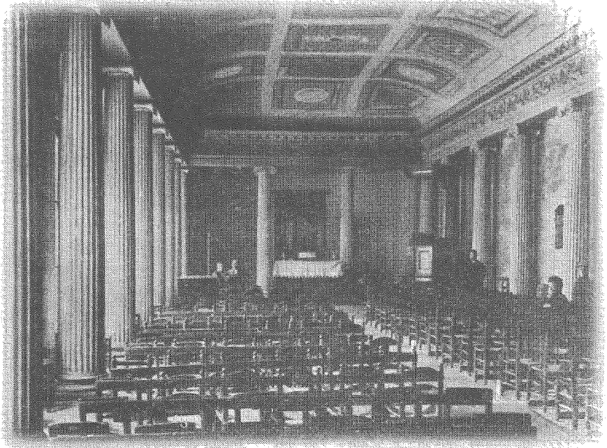
Fig. 8 - LA SALLE «EMPIRE» devenue en 1863 et pour 23 ans, l'Église luthérienne du Faubourg. On y aperçoit les colonnes, les chapiteaux, les rangées de frise et le plafond décoré de panneaux donnant à l'ensemble «assez fière allure». À la veille de la proclamation de l'Empire, le premier Consul visitant les filatures de Richard et de Lenoir fut reçu dans cette salle.
